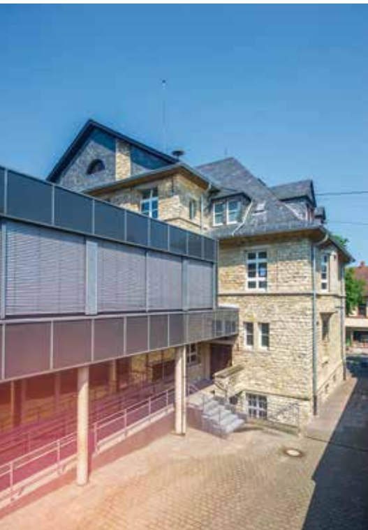
Das Stadtarchiv Ingelheim bietet mit seiner soliden Gebäudestruktur eine gute Basis für die Präventionsmaßnahmen, die im Rahmen des Sicherheitskonzeptes der SV entwickelt wurden.
